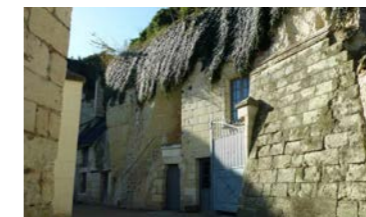
Figure 32 : Eléments spécifiques à l'architecture troglodyte (AB - architecte)
