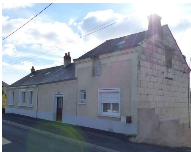
Figure 17 : Maison de levées dénaturée par des menuiseries standards et des percements inadaptés (AB - Architecte)
