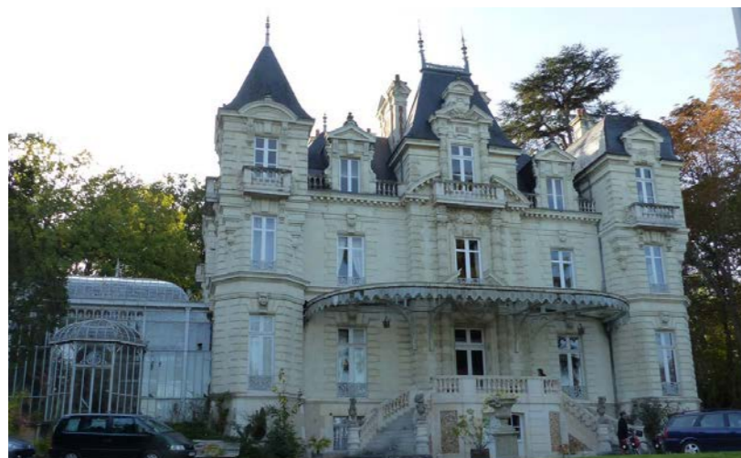
Figure 58 : Patrimoine architectural exceptionnel (AB - architecte)
