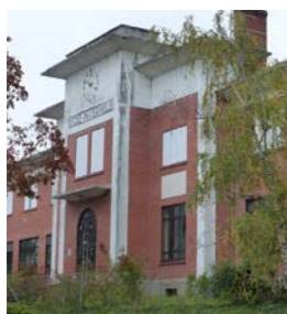
Figure 14 : L'école des Violettes - (AB - Architecte)
