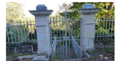
Figure 34 : Eléments architecturaux remarquables ou intéressants (AB - architecte)
