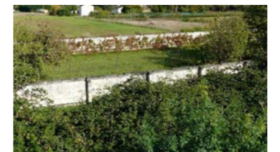
Figure 33 : Eléments de clôture intéressants (AB - architecte)
