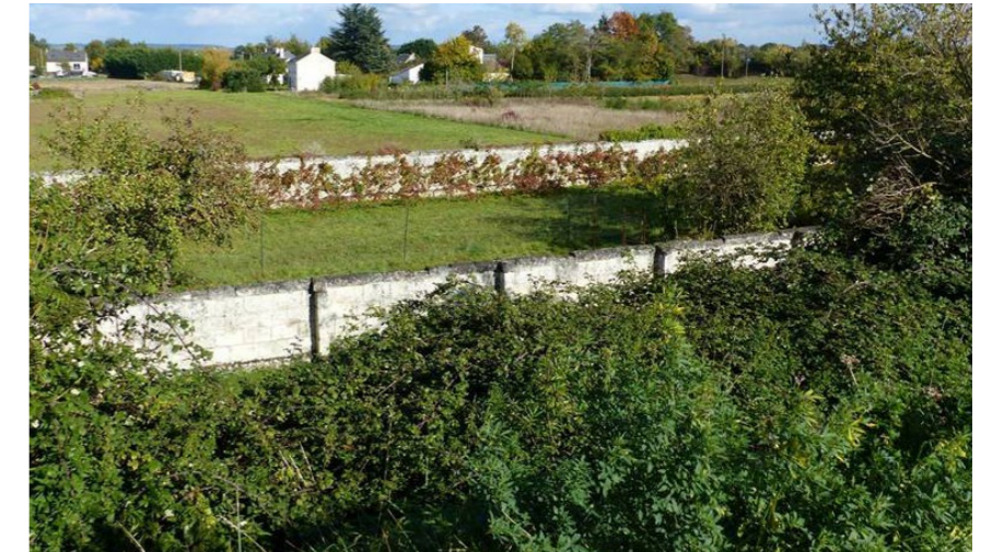
Figure 63 : Eléments de clôture intéressants (AB - architecte)
