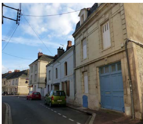
Figure 45 : Quartiers anciens (AB - Architecte)
