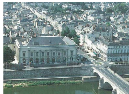
Figure 13 : La grande percée nord-sud au niveau de la Loire et le théâtre Photographie - Patrice Giraud, Région Pays de la Loire - inventaire général, ADAGP
