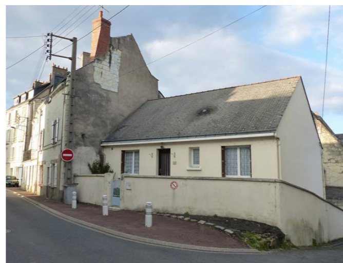
Figure 19 : Une implantation et un gabarit de construction qui ne respectent pas la morphologie originale de la rue (AB - Architecte)
