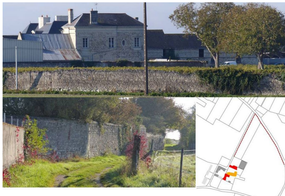
Figure 254 : Oubli dans l'ancien prieuré d'Aunis, des éléments oubliés, à repérer en patrimoine d'ensemble constituant un front homogène, clôture et élément remarquable (portail).
