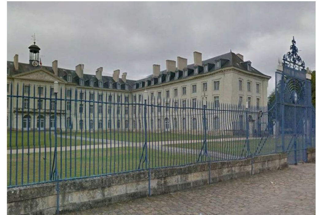
Figure 129 : Edifice militaire, Saumur centre Google Earth
