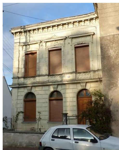
Figure 198 : Volets roulants dans le périmètre de la ZPPAUP (AB - architecte)
