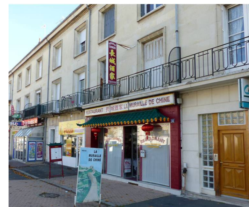
Figure 199 - 200 : Des devantures inappropriées dans le périmètre de la ZPPAUP - (AB - architecte)
