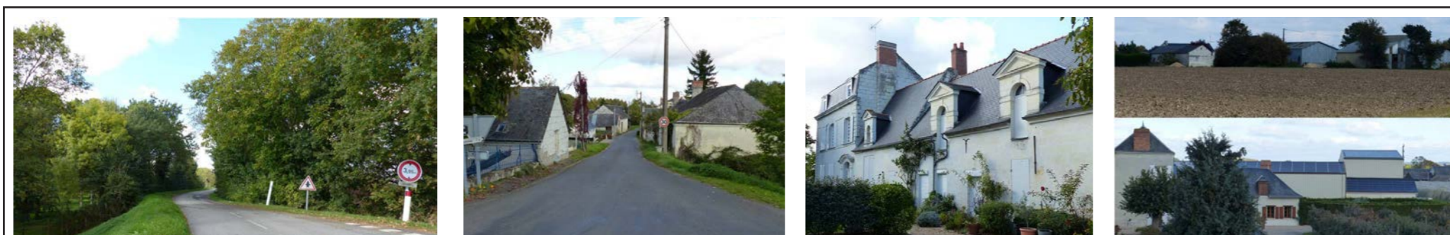
Figures 258 à 261 : La plaine maraîchère : un bâti ancien de qualité mais souvent abîmé. Des implantations de bâtiments agricoles et d'énergies renouvelables à gérer dans un secteur à enjeux paysagers et de covisibilités avec le château - (AB - architecte)
