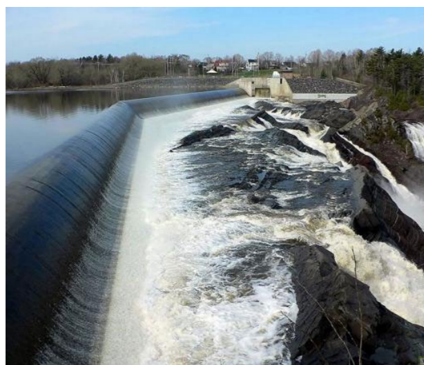
Figure 181 : Barrage Photographie libre de droit
