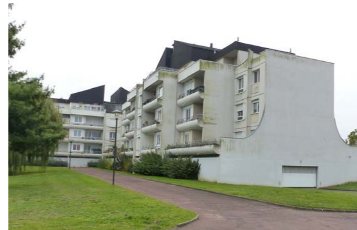
Figure 164 : Collectifs quartier des Vignes (AB - Architecte)
