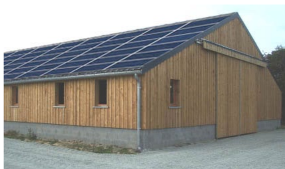
Figure 185 : implantation de capteurs sur 100% de la couverture (AB - architecte)
