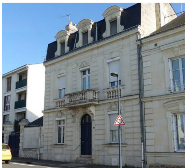
Figure 120 : Maison de ville à Bagneux (AB - Architecte)
