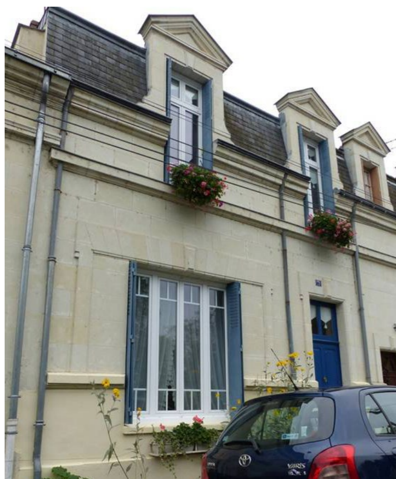
Figure 130 : Maison de bourg, île Offard (AB - Architecte)
