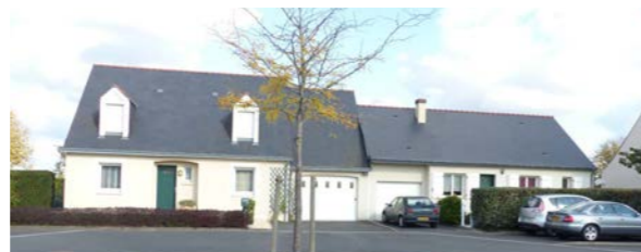
Figure 168 : Maisons accolées (AB - Architecte)
