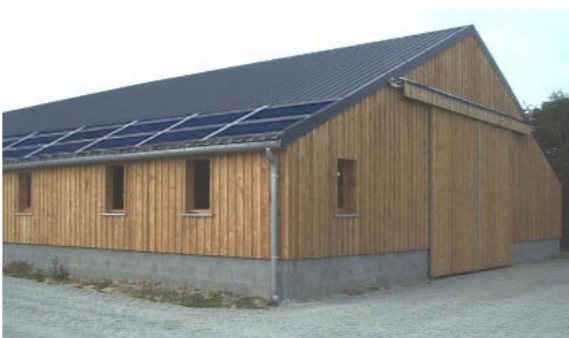
Figure 186 : implantation de capteurs en partie basse de la couverture (AB - architecte)
