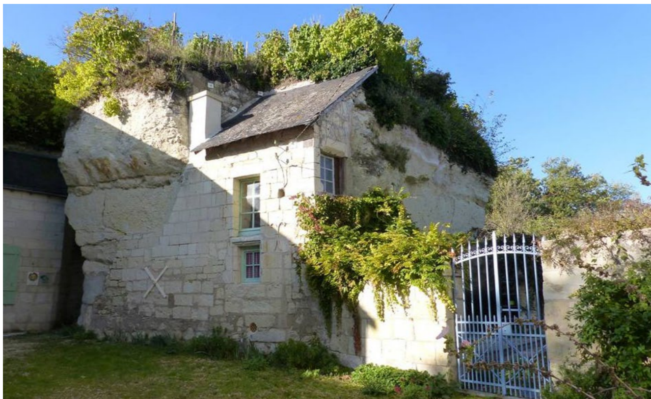
Figure 135 : Maison troglodyte, Dampierre-sur-Loire (AB - Architecte)
