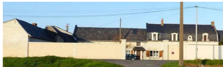
Figure 156 : Façade ouverte au sud et dépendances protectrices à l'ouest (AB - Architecte)
