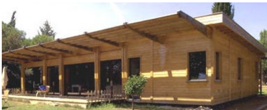
Figure 174 : Exemple d'une maison contemporaine bio-climatique : orientation sud, avec larges ouvertures et protections par brise-soleil (apport solaire l'hiver et fraîcheur l'été). Photographie libre de droit
