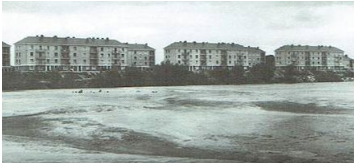
Figure 66 : La cité Millocheau Photographie de J. Decker prise vers 1955 (Archives Saumur Loire Habitat)
