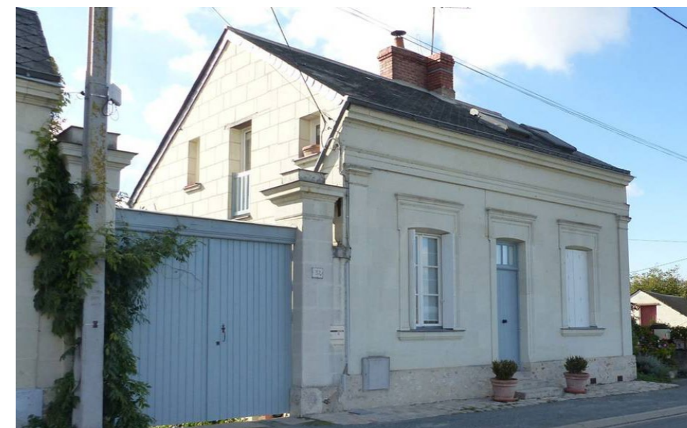
Figure 132 : Maison de levées, Saint-Lambert des Levées (AB - Architecte)
