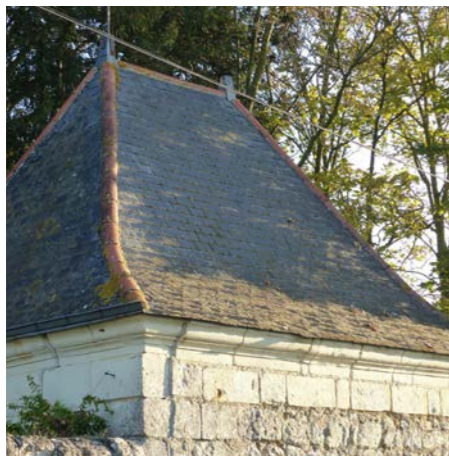
Figure 160 : Tuffeau et ardoise (AB - Architecte)
