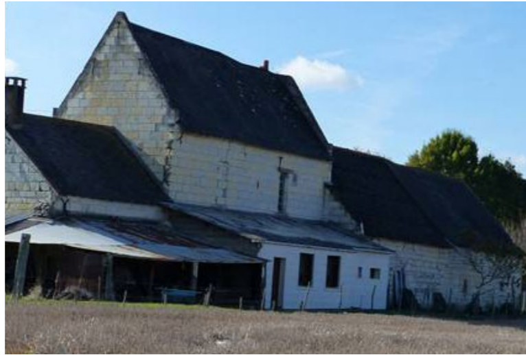
Figure 211 - 212 : Des extensions disgracieuses et faites au coup par coup (AB - architecte)
