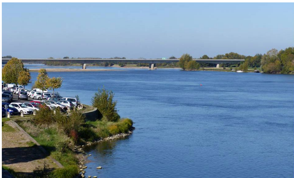
Figure 70 : Le pont du Cadre Noir (AB-Architecte)
