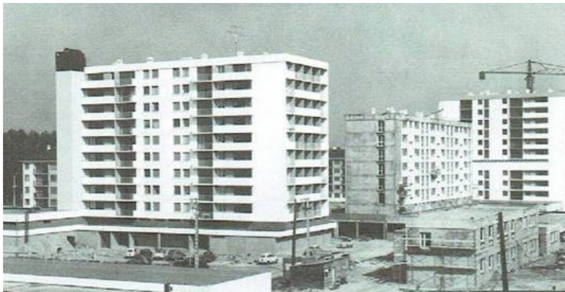
Figure 68 : Le quartier Chemin vert Photographie de J. Decker prise vers 1970 (Archives Saumur Loire Habitat)
