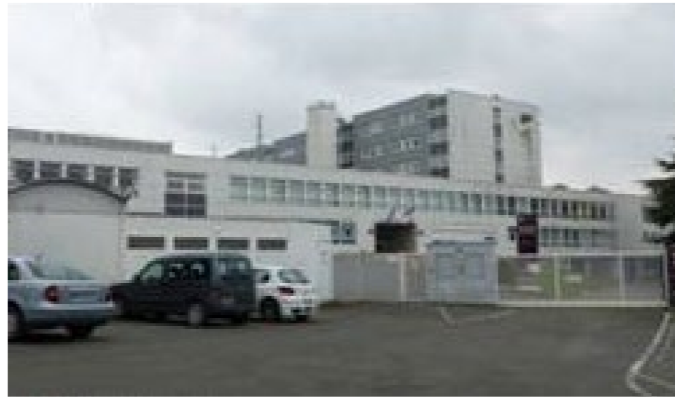
Figure 117 : Lycée Sadi Carnot - Jean Bertin (AB - Architecte)
