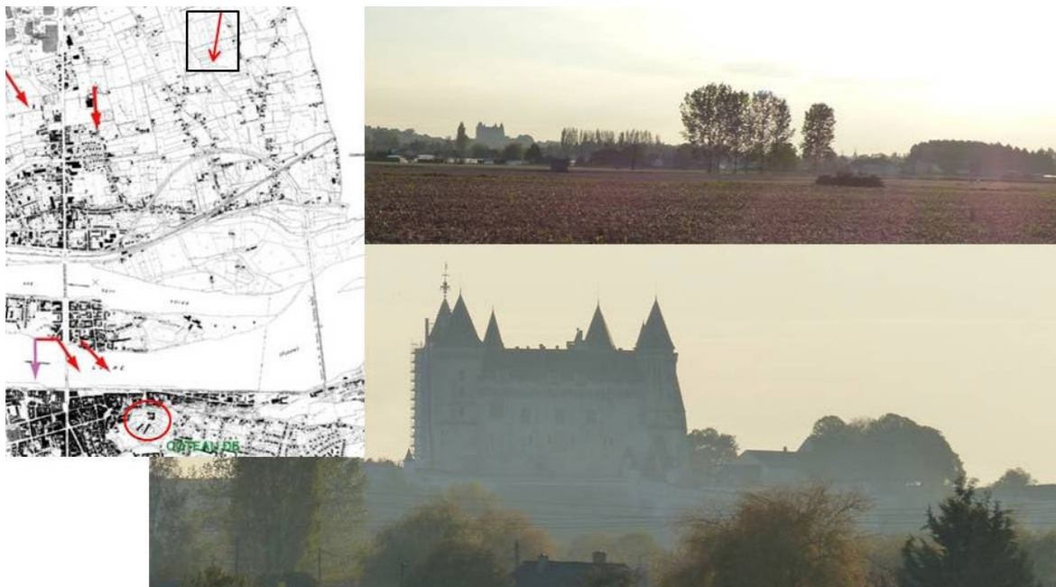
Figure 97 : Les vues du château depuis la rive droite (AB - Architecte)
