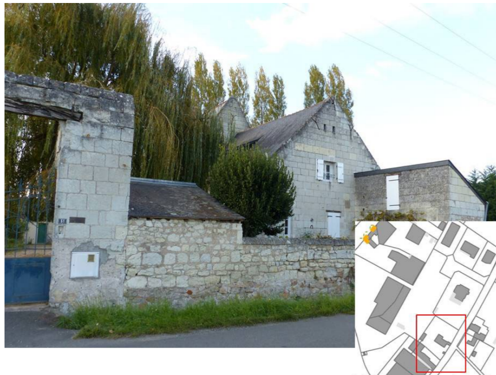
Figure 252 : Oubli à repérer en patrimoine architectural intéressant ou constitutif de l'ensemble urbain
