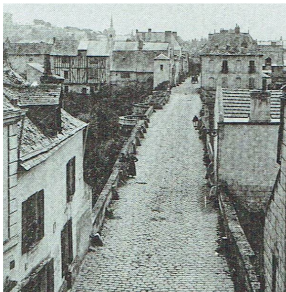
Figure 13 : Pont de la Bastille
