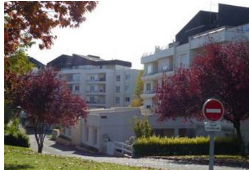
Figure 113 : Quartier des Vignes (AB - Architecte)
