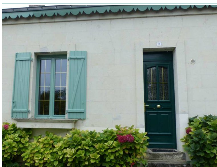
Figure 197 : Porte standardisée inadaptée dans le périmètre de la ZPPAUP (AB - architecte)
