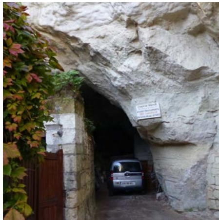
Figure 159 : Cavités dans le tuffeau (AB - Architecte)
