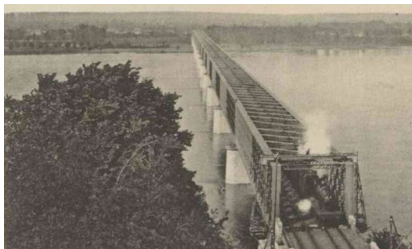
Figure 42 : Le pont métallique sur la Loire Archives départementales du Maine-et-Loire
