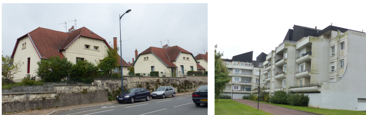
Bâti traditionnel et construction neuve, deux catégories de bâtiments pour lesquels les utilisations d'isolation extérieure et d'éléments techniques liés aux énergies renouvelables sont différentes.
