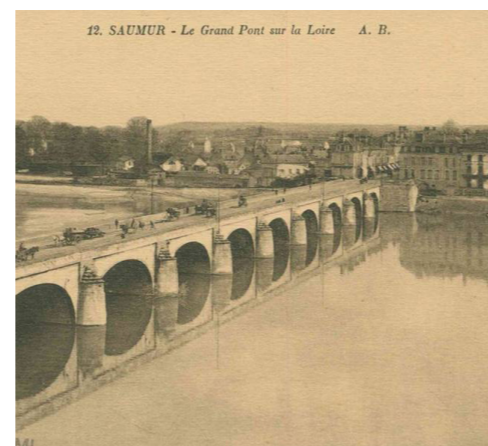
Le pont Cessart, dans l'axe de la percée urbaine de Voglie
