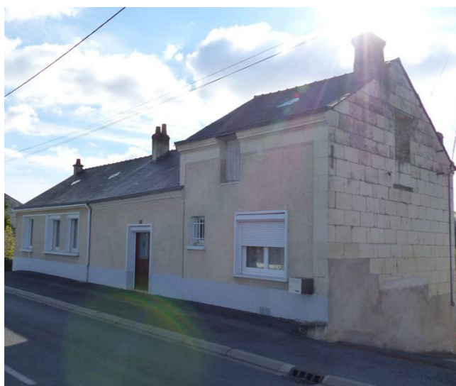
Maison de levées dénaturée par des menuiseries standards et des percements inadaptés
