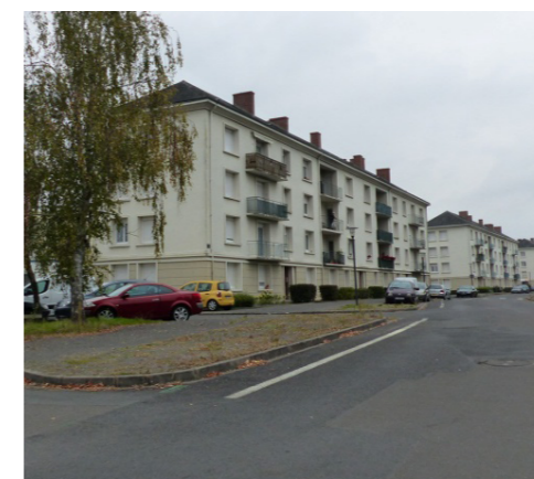
Quartiers d'immeubles de grande hauteur
