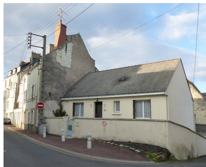
Une implantation et un gabarit de construction qui ne respectent pas la morphologie originale de la rue
