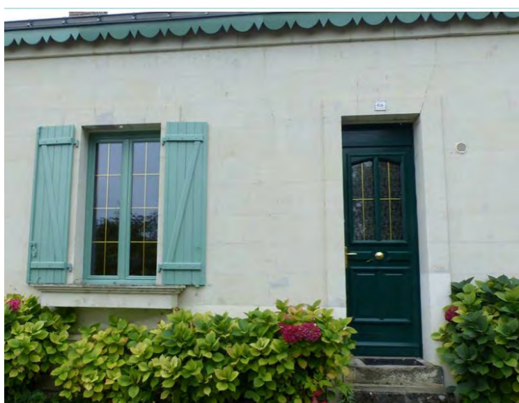
Porte standardisée inadaptée dans le périmètre de la ZPPAUP
