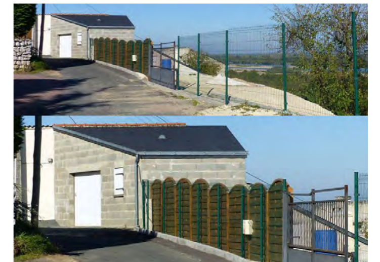
Une clôture très peu qualitative en premier plan d'un point de vue remarquable
