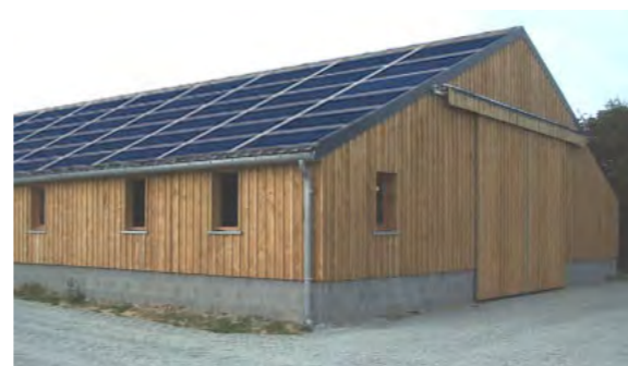
Image 1 : implantation de capteurs sur 100% de la couverture
