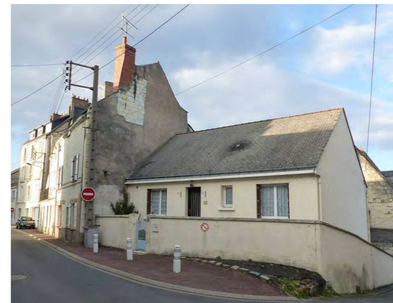
Des implantations qui ne respectent pas l'alignement du bâti ancien sur rue
