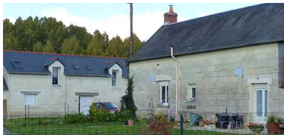
Ferme en tuffeau avec fenêtres PVC, volets roulants, ouvertures créées aux proportions inadaptées, hors du périmètre de la ZPPAUP
