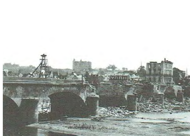
La destruction du pont des Sept-voies
