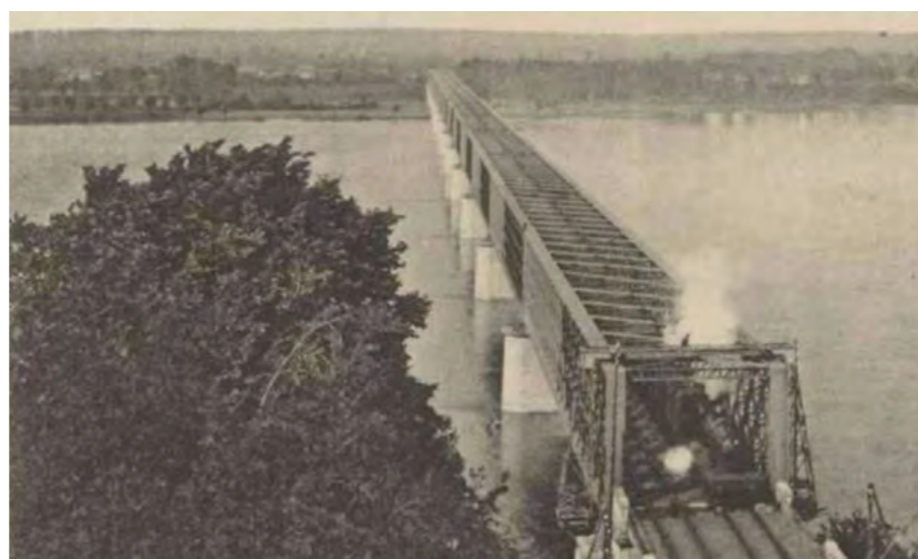
Le pont métallique sur la Loire
