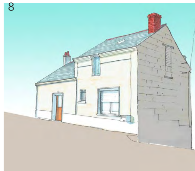
Un enduit ciment en bas de mur pignon et des câbles électriques disgracieux
